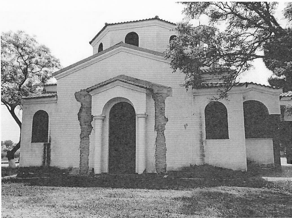
Φωτογραφία 4: Ι.Ν. Αγίας Σοφίας όπου θα κατασκευαστεί περιμετρική αποστράγγιση
